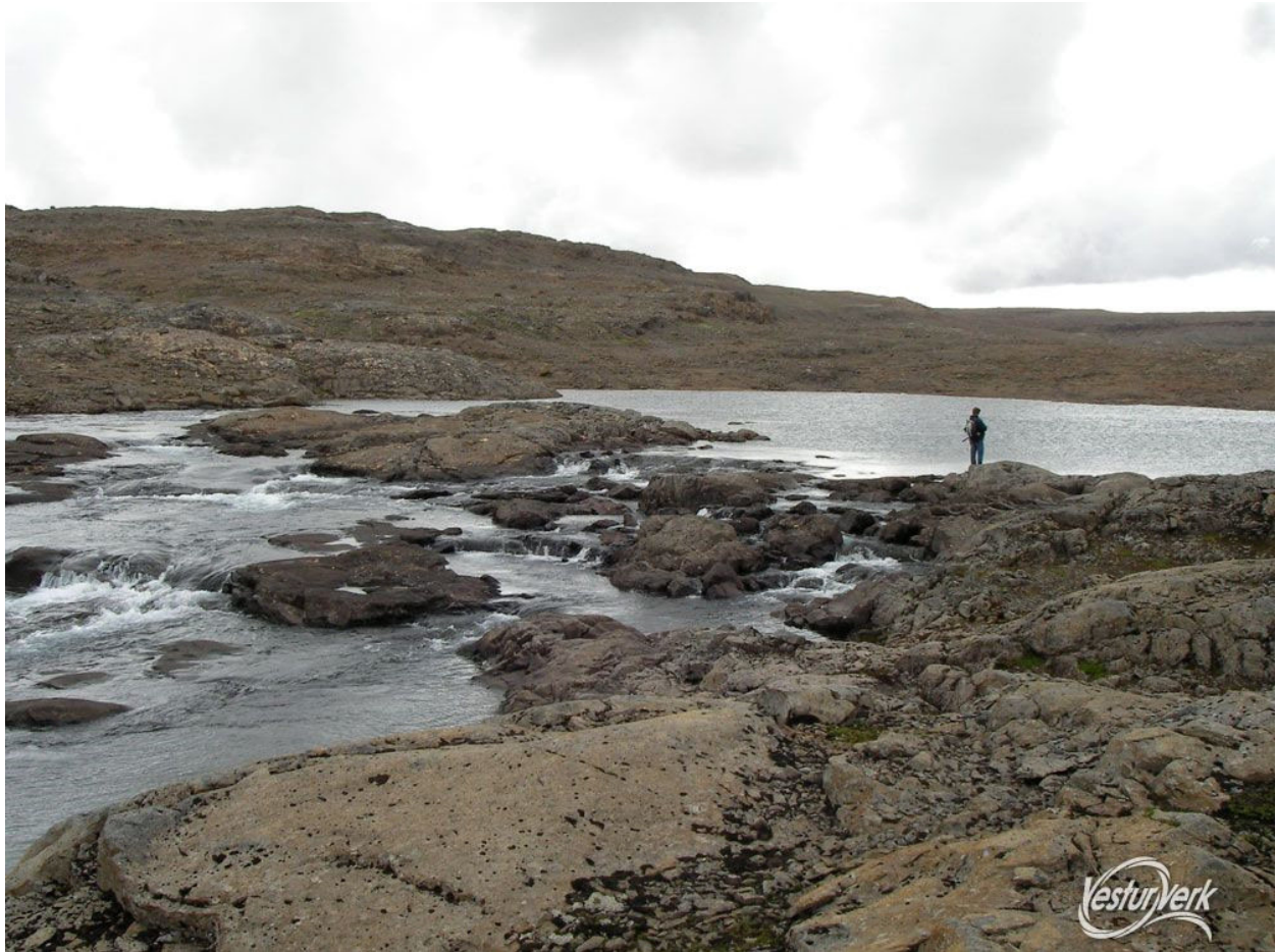
Mynd 4.6 Væntanlegt stíflustæði við Neðra-Hvalárvatn. Horft er til suðvesturs. Ljósmynd Vesturverk
